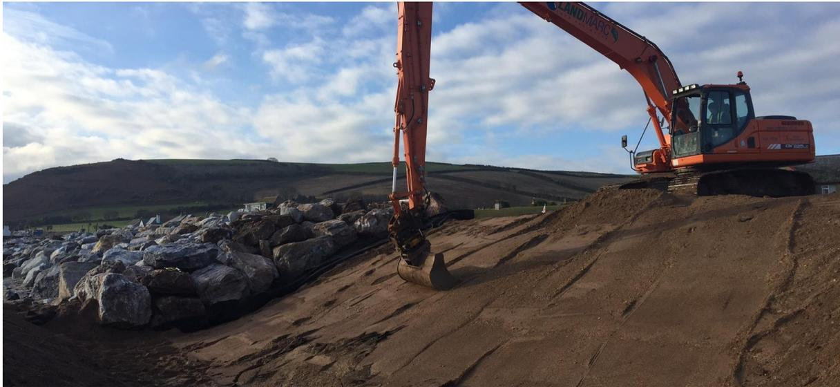
Fase di profilatura del pendio per poter posare la rete e successivamente ospitare le “celle” costituenti il Sistema.
