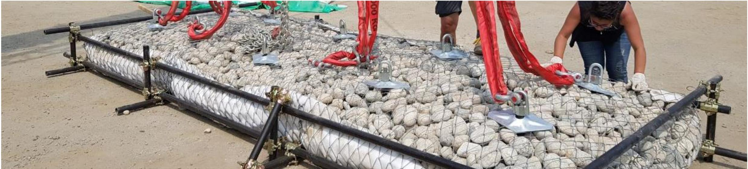
La “Trapunta” è un *struttura tridimensionale* del peso variabile tra 7 e 10 T a seconda delle dimensioni, realizzata in rete a maglia romboidale TECCO in acciaio INOX, mediante l’ausilio di un telaio realizzato in tubolari.
