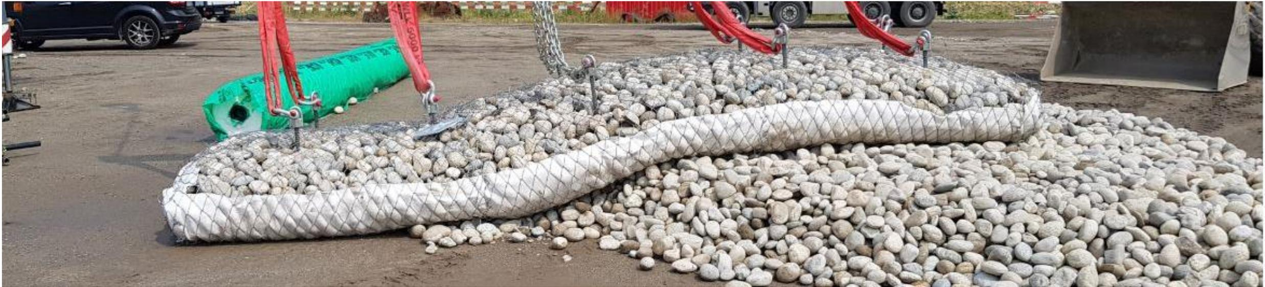
La “Trapunta” è flessibile e la sua configurazione le permette di adagiarsi stabilmente su qualsiasi profilo di terreno mantenendo intatte le sue caratteristiche tecniche.
