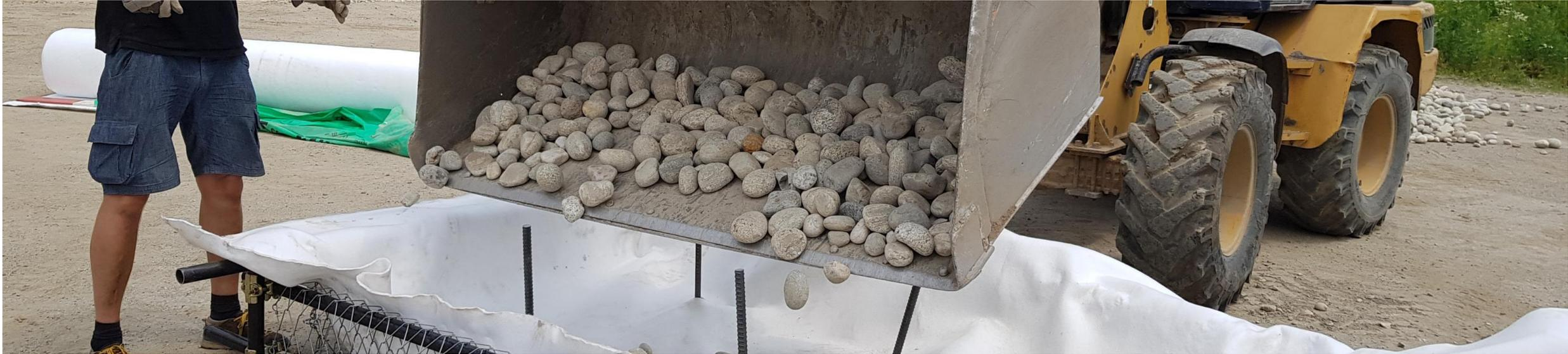
All'interno del telaio tubolare viene stesa la rete TECCO sopra la quale viene posato un geotessile di separazione. Vengono posizionati, a distanza di un metro l'uno dall'altro, sei ancoraggi filettati alla cui base vengono posizionate delle piastre metalliche. La struttura è riempita per uno spessore di 0.40 m con inerti di pezzatura 100/120 mm.
