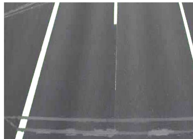
NTSG: sensore in fibra ottica
