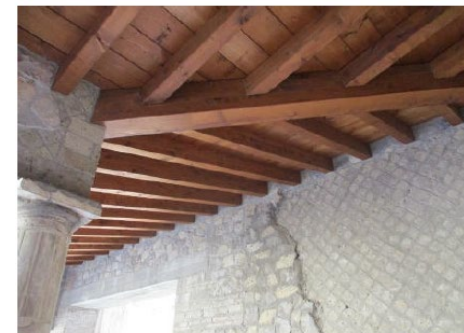
copertura con travi in legno e tavolato in legno
