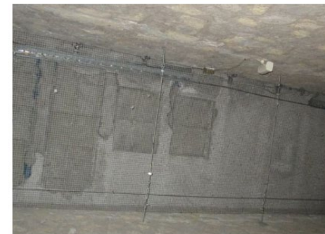
solai in cemento armato con pignatte in lapillo e cemento
