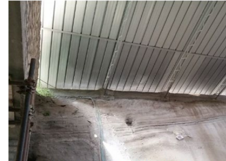
carpenteria con travi reticolari e lamiera grecata
