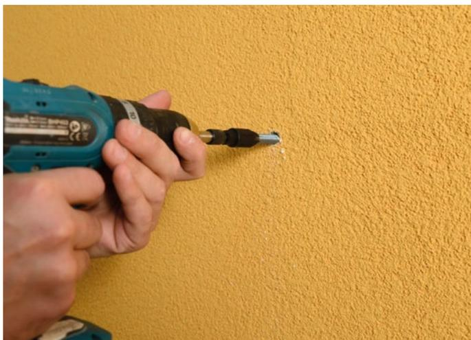
Inserire l'Elemento di Fissaggio per Carichi Medi all'interno del foro realizzato senza il tassello affinché il cono nero in plastica rinforzato autofilettante realizzi l'alloggiamento per il tassello all'interno dello strato isolante. Rimuovere l'Elemento di Fissaggio dal foro e procedere alla pulizia del foro stesso.
