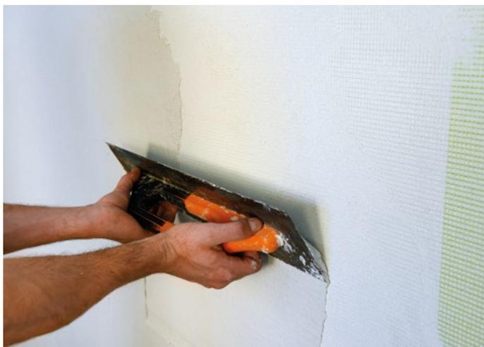
A completa asciugatura della prima mano di Adesivo&Rasante e verificata la tenuta della rete di armatura al suo interno, procedere con l'applicazione della seconda mano di rasatura a coprire completamente la rete, per ottenere una superficie liscia e planare.
