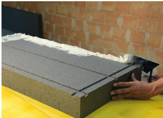
Applicare l'Adesivo&Rasante sull'apposita scanalatura perimetrale in modo che lo stesso vi penetri all'interno, creando un cordolo di circa 5 cm di larghezza.
