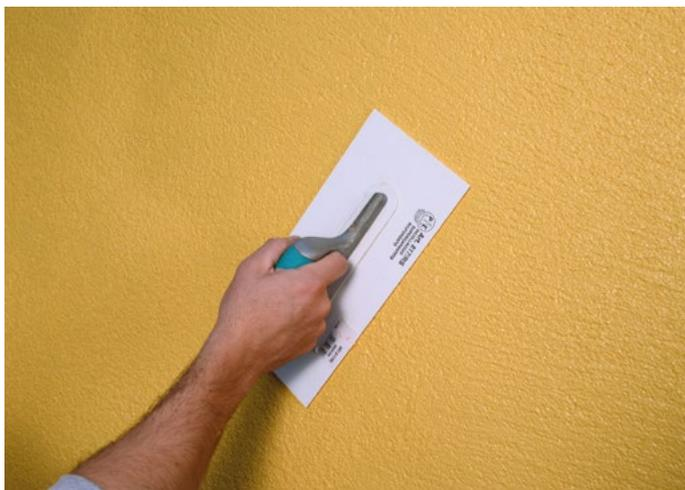
Per ultimare la finitura procedere con la frattazzatura mediante frattazzo in plastica, con movimenti circolari.
