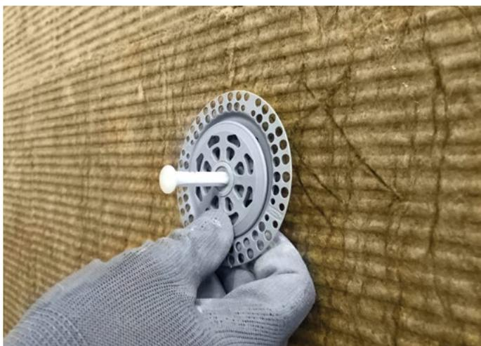
Dopo aver pulito il foro realizzato, inserire il tassello fornito preassemblato, in abbinamento al Disco di Fissaggio Maggiorato, all'interno del foro stesso. Il tassello dovrà entrare con facilità, fino a che la testa del tassello non risulti in contatto con la superficie del pannello. Qualora il tassello abbia difficoltà a entrare, non forzare l'inserimento e procedere con un'ulteriore pulizia del foro.
