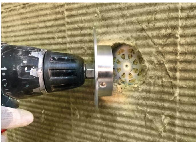
Procedere all'avvitamento del chiodo: grazie all'ausilio della fresa il chiodo verrà avvitato all'interno del tassello e contestualmente avverrà la fresatura del pannello isolante. Il tassello risulterà quindi incassato di 1,5 cm all'interno del pannello.
