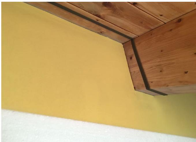
Incollare sul profilo dei travetti in legno, alla corretta distanza considerando lo spessore del pannello isolante (filo esterno pannello isolante), il Nastro di Guarnizione Comprimitibile, avendo cura di tagliare pezzi di dimensioni limitate (massimo 50 cm di lunghezza). Per la realizzazione di angoli, si consiglia di applicare il Nastro in due porzioni separate così da garantire la corretta espansione anche in prossimità dello spigolo.
