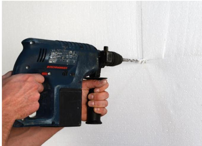
In base alla tipologia di supporto, realizzare un foro perpendicolare al supporto stesso con idonea punta del diametro di 8 mm (vedere la documentazione tecnica del prodotto). Il foro dovrà risultare almeno 4 cm più lungo della lunghezza complessiva del tassello. La metodologia di foratura è determinata dalla tipologia di supporto:
