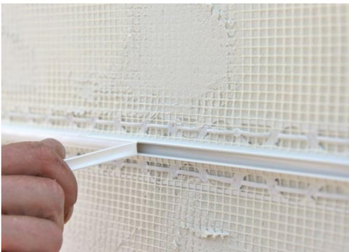
Se necessario, è possibile rimuovere la copertura bianca del Giunto di Dilatazione Plus e riempire lo spazio con apposito sigillante silanico neutro.
