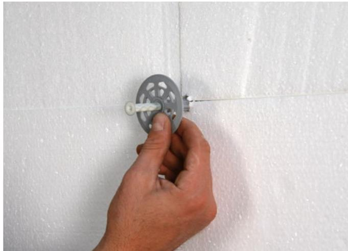
Dopo aver pulito il foro realizzato, inserire il tassello fornito preassemblato all'interno del foro stesso. Il tassello dovrà entrare con facilità, fino a che la testa del tassello non risulti in contatto con la superficie del pannello. Qualora il tassello abbia difficoltà a entrare, non forzare l'inserimento e procedere con un'ulteriore pulizia del foro.
