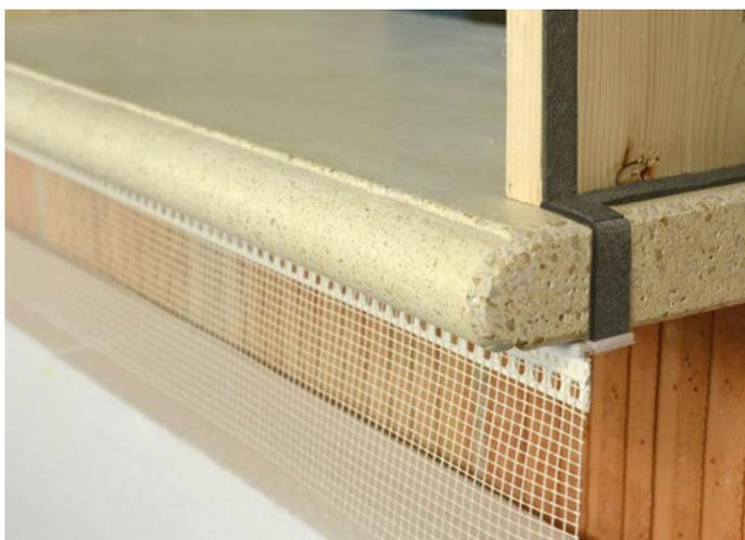
Applicare il nastro di guarnizione comprimibile tagliandolo in corrispondenza degli spigoli dell'elemento di facciata in modo che espanda sempre parallelamente ad esso.
