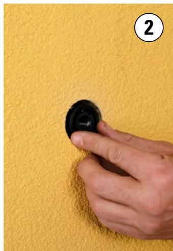
**1\_** Procedere all'inserimento di un idoneo quantitativo di ancorante chimico ad iniezione e inserire manualmente l'Elemento di Fissaggio per Carichi Pesanti all'interno del foro.
