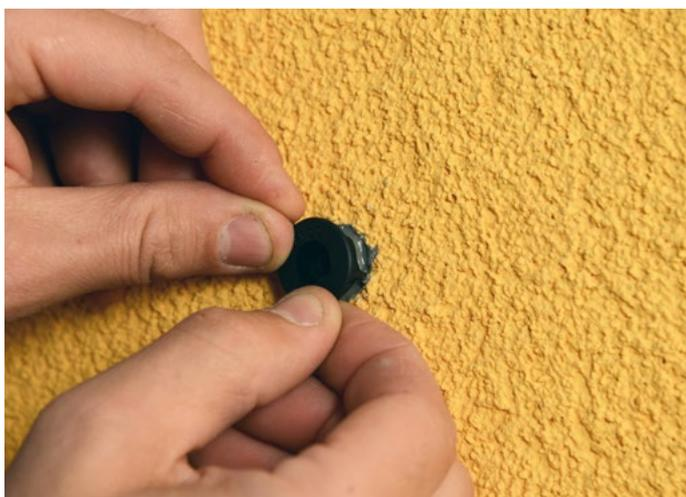
Se necessario, applicare l'apposito cappuccio sull'Elemento di Fissaggio e l'apposito tassello per il successivo inserimento della vite.
