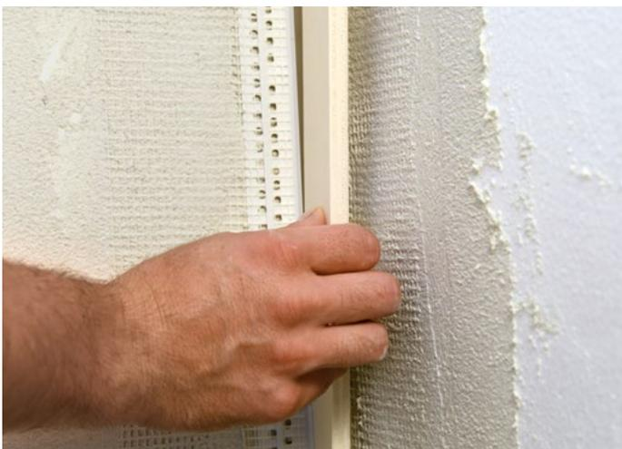
Per evitare che il giunto si sporchi nelle lavorazioni successive e per assicurare la planarità e una lavorazione più precisa, inserire all'interno un pezzo di legno o di EPS correttamente tagliato e rimuoverlo solo a lavorazioni ultimate.
