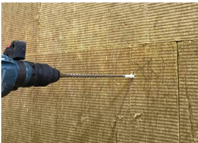
In base alla tipologia di supporto, realizzare un foro perpendicolare al supporto stesso con idonea punta del diametro di 8 mm (vedere la documentazione tecnica del prodotto).
