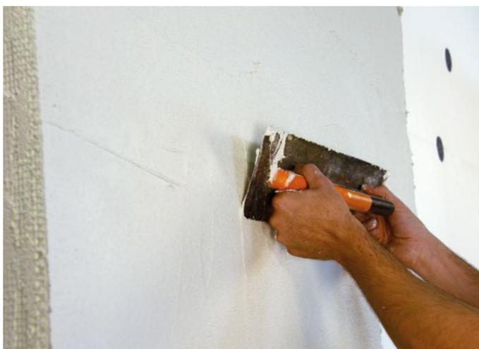
Applicare sullo strato isolante precedentemente preparato lo strato di Adesivo&Rasante, applicato a mano con spatola in acciaio o a macchina. Realizzare uno spessore idoneo per l'incollaggio della rete di armatura in fibra di vetro alcali resistente.
