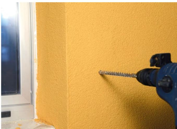
Procedere con la realizzazione del foro, mediante trapano con apposita punta di diametro e lunghezza idonea all'Elemento di Fissaggio da applicare. Prestare particolare attenzione alla modalità di foratura per garantire la tenuta (vedi cap. 6 – Tassellatura).
