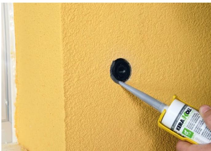
Ad indurimento completo dell'ancorante chimico, effettuare la registrazione dell'Elemento di Fissaggio (se necessario). Procedere poi con l'applicazione di apposito sigillante silanico neutro, per garantire la tenuta all'acqua e assorbire le tensioni derivanti dai carichi applicati.
