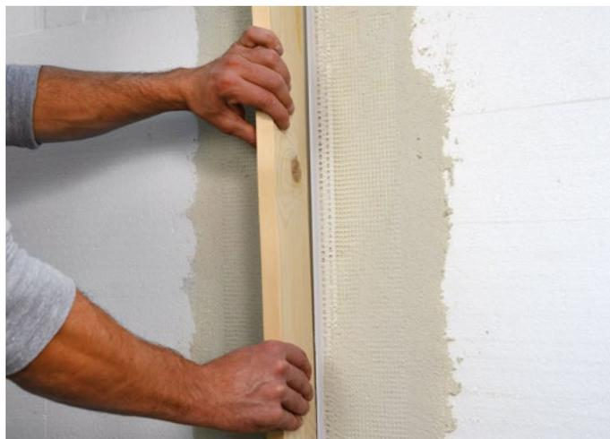
Per evitare che il giunto si sporchi nelle lavorazioni successive e per assicurare la planarità e una lavorazione più precisa, inserire all'interno un pezzo di legno o di EPS correttamente tagliato e rimuoverlo solo a lavorazioni ultimate.
