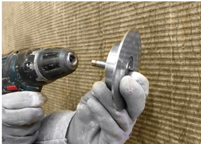
Applicare sull'avvitatore predisposto con attacco SDS la Fresa Metallica Bivalente per l'infissione di tasselli avvitabili, dotato di punta torx. Grazie a questo attrezzo è possibile applicare i tasselli perfettamente a filo pannello.
