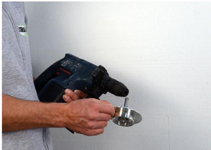
Applicare sull'avvitatore predisposto con attacco SDS la Fresa Metallica Bivalente in modalità fresa per l'infissione di tasselli avvitabili all'interno dei pannelli isolanti.
