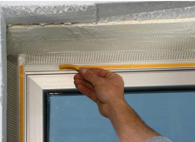
Rimuovere la protezione arancione dalla sezione del Profilo per Finestre e incollare uno spezzone di telo in nylon preventivamente sagomato a protezione dell'infisso.
