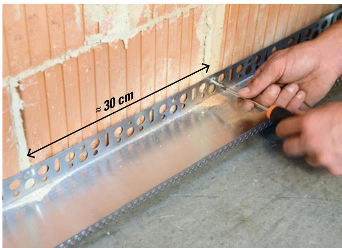
Tassellare la Base di Partenza al supporto mediante l'uso di appositi tasselli da muro, in base alla tipologia di supporto. L'interasse tra i tasselli deve essere di circa 30 cm al fine di evitare flessioni della Base di Partenza sotto il peso proprio del sistema, quando l'Adesivo&Rasante non è ancora andato in presa e indurimento.
