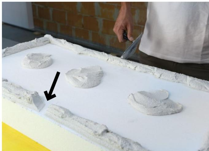
Interrompere la continuità del cordolo realizzato effettuandovi un taglio, al fine di evitare l'"effetto ventosa" in fase di pressatura del pannello al supporto.
