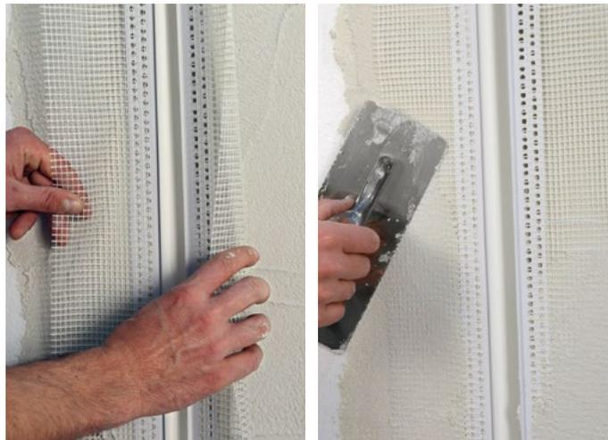
Applicare il Giunto di Dilatazione Facciata all'interno dello spazio tra i pannelli e rasare le retine in fibra di vetro di collegamento.
