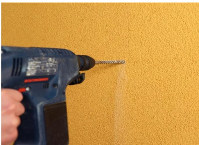
Per l'applicazione di carichi di media entità come pluviali, corrimano, ecc. al sistema a cappotto ultimato utilizzare l'apposito Elemento di Fissaggio per Carichi Medi, costituito da un chiodo in acciaio a taglio termico da fissare al supporto retrostante e un tassello in plastica. Realizzare un foro della lunghezza corretta all'interno del supporto, prestando attenzione alla modalità di foratura (vedi cap. 6 – Tassellatura).
