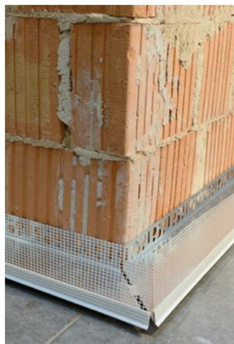
Applicare il Rompigoccia per Base di Partenza innestato a scorrimento sulla parte frontale della Base, al fine di evitare microfessurazioni nella zona di contatto tra pannello isolante e lamiera.
