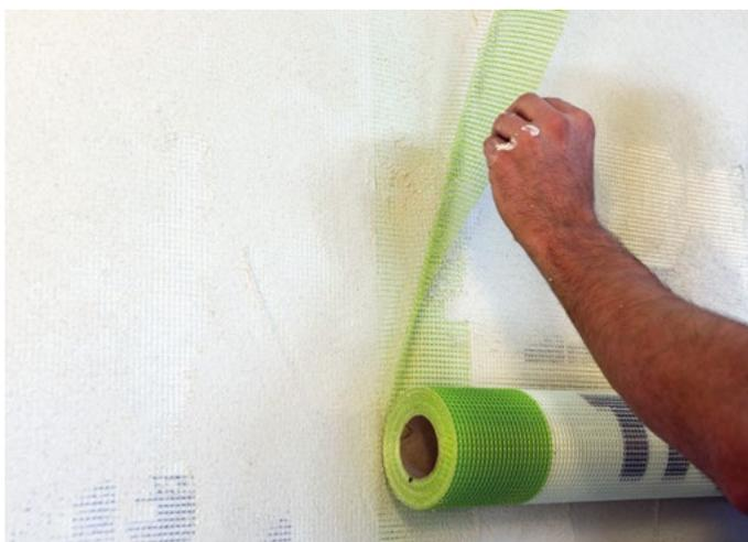
Sormontare le fasce di rete per almeno 10 cm, utilizzando le bande colorate come linea guida per verificare che il sormonto sia sempre eseguito.
