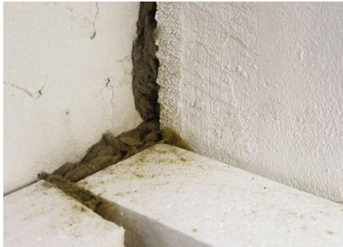
Interrompere la continuità dei pannelli isolanti seguendo la discontinuità delle basi di partenza. Se necessario inserire all'interno dello spazio creato apposito materiale isolante sfuso comprimibile per evitare la formazione di un ponte termico.
