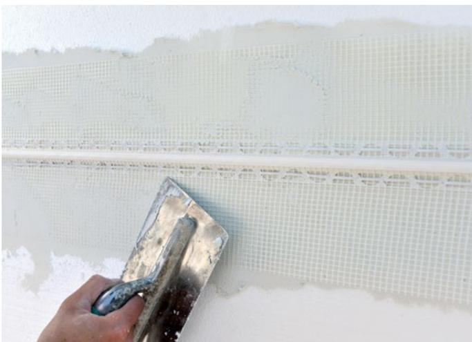
Incollare il corso di pannelli isolanti, sovrastante il giunto, correttamente separati. Se necessario riempire lo spazio vuoto con materiale isolante sfuso comprimibile per eliminare il ponte termico. Rasare le retine in fibra di vetro del Giunto di Dilatazione Plus avendo cura di applicare il giunto con la porzione di polipropilene bianca rivolta verso l'esterno.
