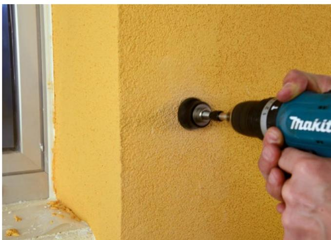
Procedere all'avvitamento dell'elemento di fissaggio senza calza all'interno del foro così da realizzare l'alloggiamento superficiale. Estrarre il tassello e procedere a una pulizia accurata del foro. Rimuovere il seghetto e riutilizzarlo per applicazioni successive.
