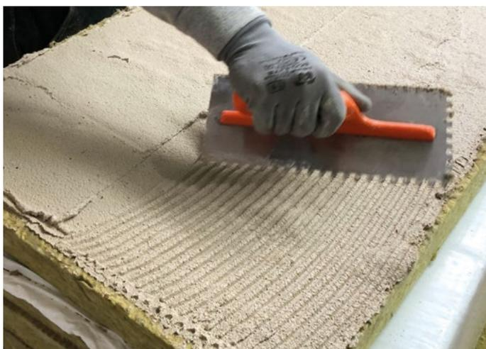
Procedere con l'applicazione di un ulteriore strato di Adesivo&Rasante utilizzando apposita spatola dentata con dente 10 mm così da realizzare un idoneo spessore di prodotto. Distanziarsi 1 cm dal bordo del pannello in modo da evitare la fuoriuscita dell'Adesivo&Rasante in fase di applicazione e pressatura del pannello al supporto.
