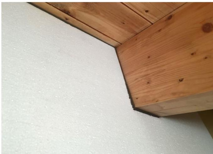
Procedere velocemente all'incollaggio del pannello isolante precedentemente sagomato a misura, in modo che vada in battuta contro il Nastro Comprimitibile, prima che il Nastro stesso si sia espanso.
