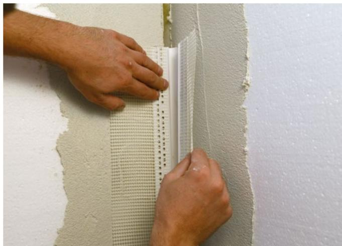
Applicare l'apposito profilo per giunti di dilatazione ad angolo avendo cura di inserire la parte in polipropilene bianca all'interno dello spazio lasciato tra i pannelli.
