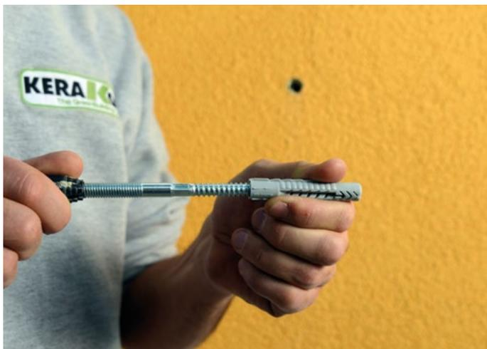
Applicare il tassello in plastica grigio sulla punta del chiodo in acciaio e procedere all'inserimento all'interno del foro realizzato dall'Elemento di Fissaggio per Carichi Medi.
