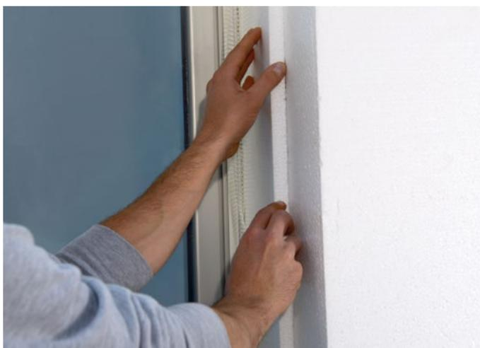
Dopo aver tagliato a misura il pannello isolante, per isolare termicamente la spalletta e l'architrave della finestra, procedere con l'incollaggio mediante l'Adesivo&Rasante da cappotto.
