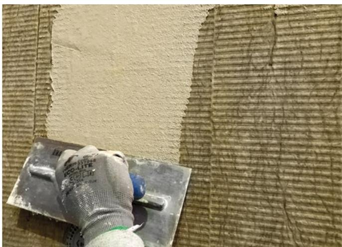
Eventuali irregolarità dei pannelli isolanti in Lana Minerale devono essere livellate mediante applicazione di una mano di Adesivo&Rasante prima di passare a lavorazioni successive. Controllare la planarità della superficie ottenuta.
