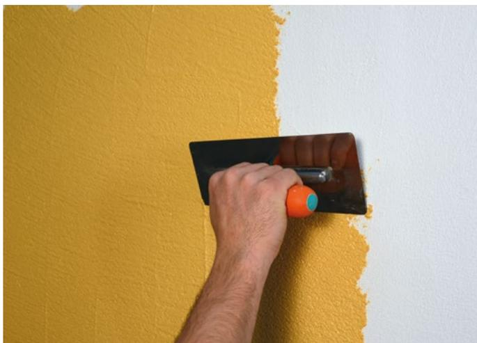
Dopo circa 24 ore, applicare l'intonachino a spessore mediante l'uso di apposita spatola in acciaio. L'applicazione deve avvenire dall'alto verso il basso, con movimenti semicircolari, avendo cura di eliminare qualsiasi ripresa di mano.
