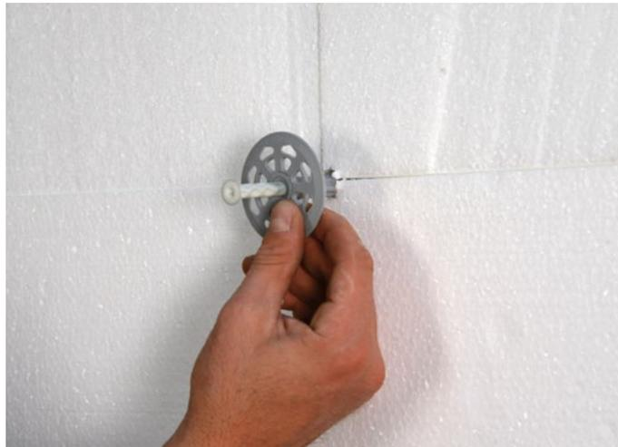
Dopo aver pulito il foro realizzato, inserire il tassello fornito preassemblato all'interno del foro stesso. Il tassello dovrà entrare con facilità, fino a che la testa del tassello non risulti in contatto con la superficie del pannello. Qualora il tassello abbia difficoltà a entrare, non forzare l'inserimento e procedere con un'ulteriore pulizia del foro.
