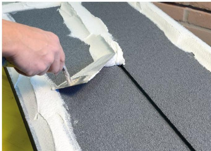
Applicare l'Adesivo&Rasante anche sulla scanalatura centrale, allo stesso modo di quella perimetrale. In questo modo si genera una struttura di irrigidimento che vincola il pannello al supporto già dai primi minuti dopo l'incollaggio.
