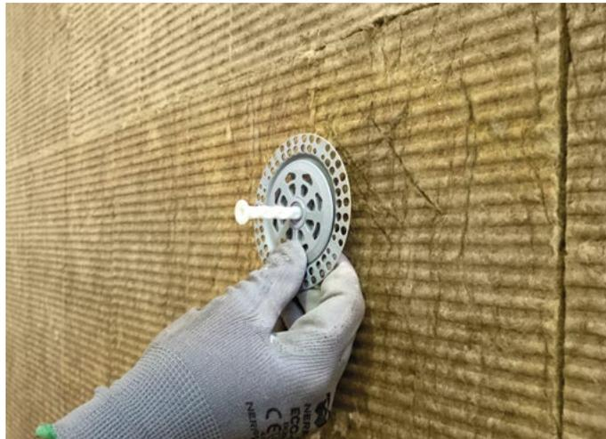
Dopo aver pulito il foro realizzato, inserire il tassello fornito preassemblato, in abbinamento al Disco di Fissaggio Maggiorato, all'interno del foro stesso. Il tassello dovrà entrare con facilità, fino a che la testa del tassello non risulti in contatto con la superficie del pannello. Qualora il tassello abbia difficoltà a entrare, non forzare l'inserimento e procedere con un'ulteriore pulizia del foro.
