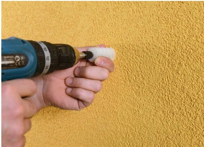
Avvitare l'elemento di fissaggio al cappotto, in modo che risulti all'interno del pannello isolante. La testa del tassello sarà perfettamente a filo con il sistema a cappotto ultimato e permetterà l'infissione dei carichi leggeri.
