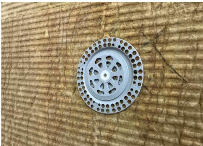
Procedere all'avvitamento del chiodo sul tassello: l'avvitamento si bloccherà automaticamente quando la Fresa Metallica Bivalente arriverà in contatto con il pannello isolante.
