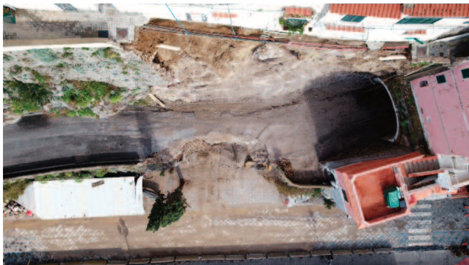
3. Foto aerea del crollo successivamente alla rimozione dei detriti.
