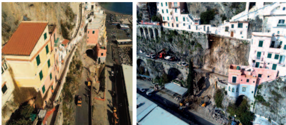
1-2. Foto aeree del crollo estratte dal rilievo con il drone.
