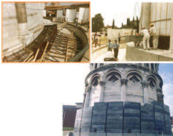
9. L'intervento provvisorio con contrappeso. Dall'alto, in senso orario: la costruzione della trave anulare; la posa del primo lingotto; la catasta di lingotti ultimata nel gennaio 1994..
