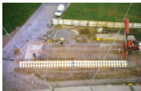
12. I quarantuno fori della sottoescavazione definitiva visti dalla Torre, Sono anche visibili gli stralli dell'opera di presidio.
