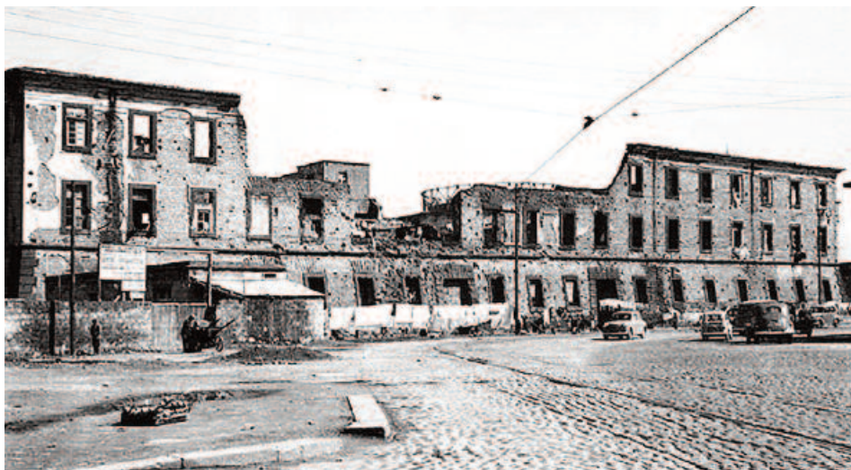
4. Napoli, Ex Caserma Cavallerizza alla Maddalena. Lo stato post bellico dell'edificio.
