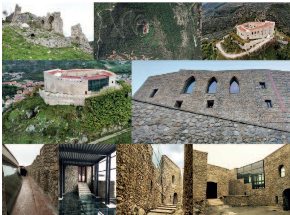
6. Giffoni Valle Piana (SA), Progettazione esecutiva ed esecuzione dei lavori di Rinascita del Borgo medioevale di Terravecchia, Restauro Castello.
