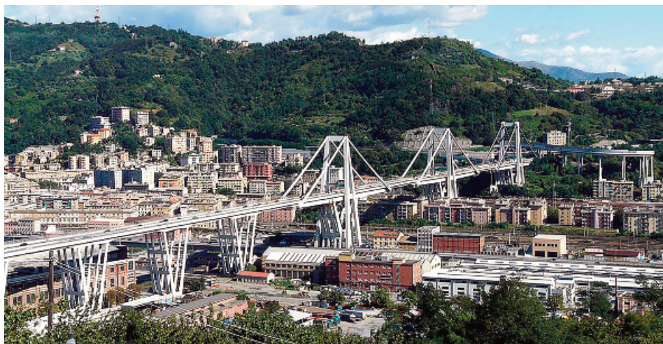
1. Genova, Viadotto Polcevera - Ponte Morandi (prima del crollo) 2017.
