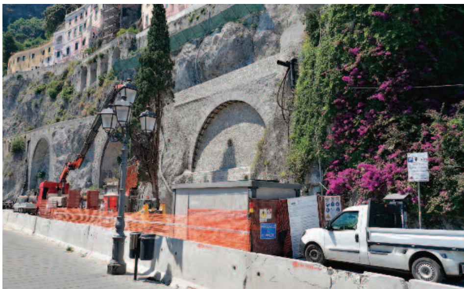
9. Foto post intervento.
