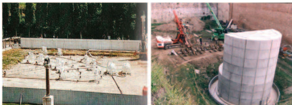
10. A sinistra: il campo sperimentale per l'elettroosmosi; a destra: il campo sperimentale per la sottoescavazione..
