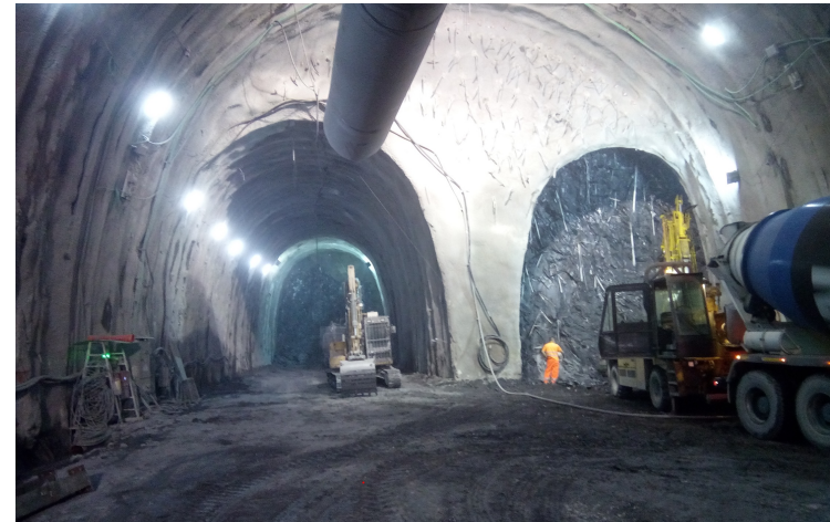
Esempio dello scavo del “Camerone C GN13” linea Av tra Genova e Milano (cortesia Italferr SpA).
